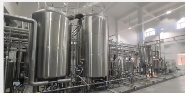
布赫啤酒过滤系统
